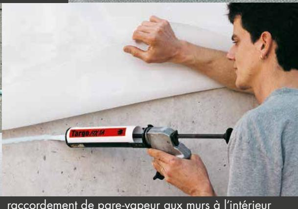
raccordement de pare-vapeur aux murs à l'intérieur
