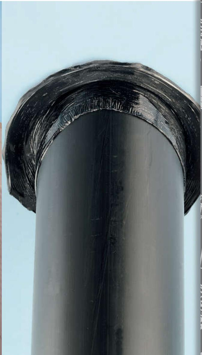
Dunstrohr-Durchdringung luftdicht anschliessen
