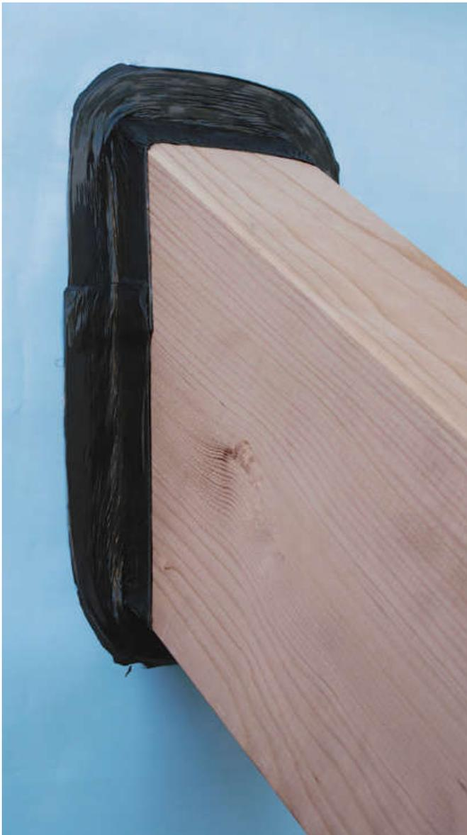
Sparren-Durchdringung luftdicht anschliessen
